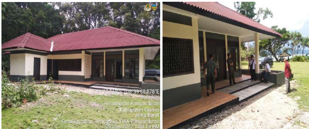
Gambar 19 Renovasi Wisma Rengganis TWA Pangandaran
