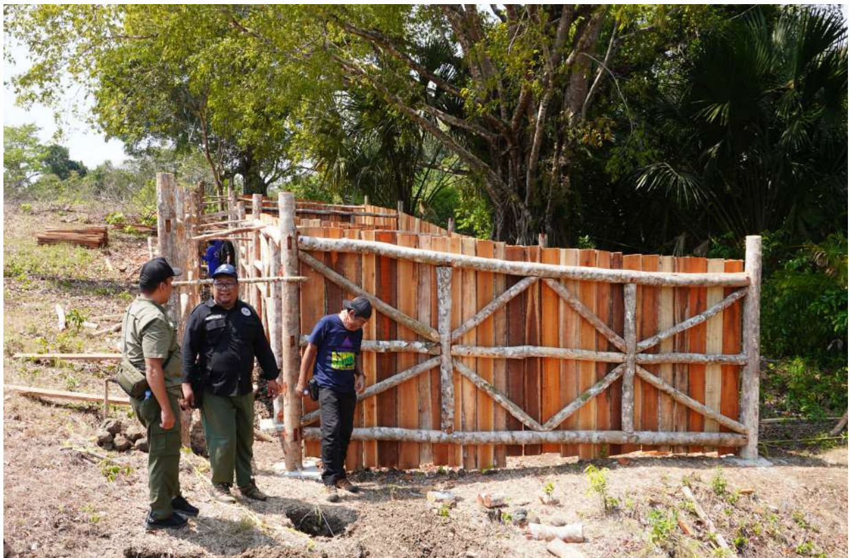
Gambar 59. Pembuatan Kandang Habitasi Banteng di CA Pananjung Pangandaran
